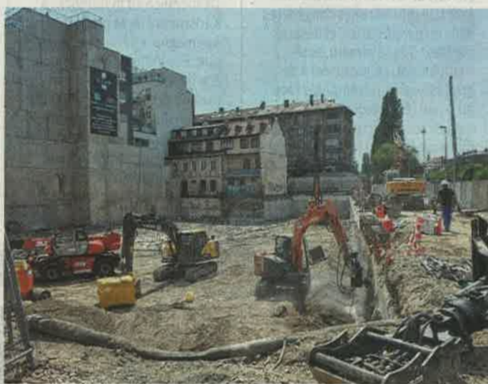
Les fondations spéciales sont bientôt finies. Le gros œuvre de ce bâtiment de cinq étages, plus trois étages en sous-sol, doit débuter début août. PHOTO DNA - MICHEL FRISON
